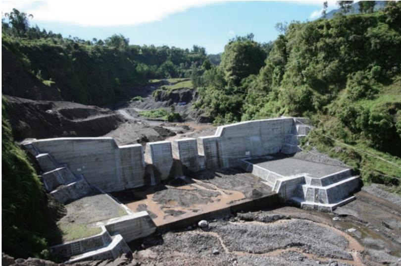
日本の支援でメラピ山に建設された砂防ダム。一本の川に複数建設され、土石流を所要所でせき止める
