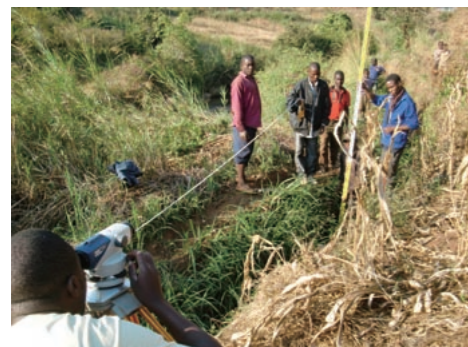
宮城県が供与した機材を使い、新しい水路を作るために土地の高低差を測量中
