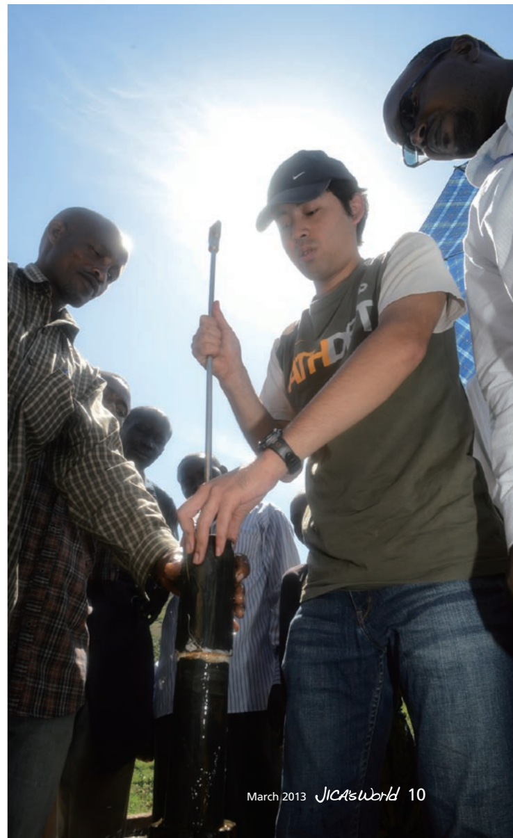
水管理組合のメンバーと協力してハンドポンプを修理
