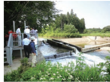
川をせき止めて水位を上げ、水路に水を取り入れる宮城県内のかんがい施設を視察
