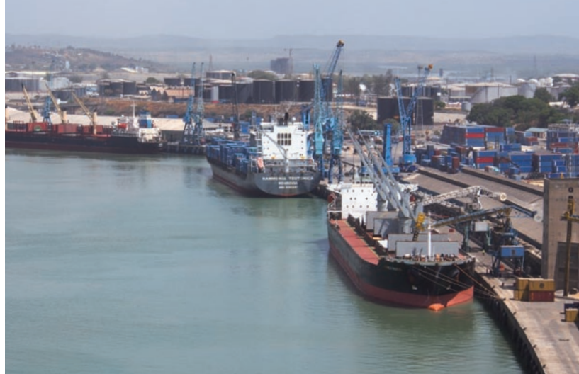
ケニア唯一の国際貿易港であるモンバサ港では、貨物取扱量がこの10年で約3倍に。日本の支援により拡張工事が進められている
