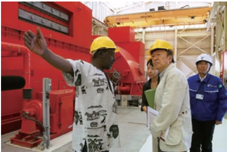
現地企業の責任者から、発電所の運営状況について説明を受ける
