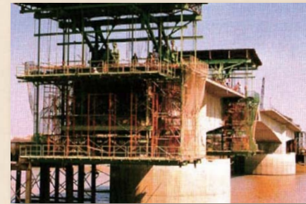
ツワナ橋の建設現場。ミャンマーの技術者たちは理論を実践で生かす
