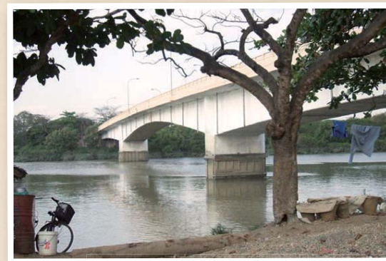
ミャンマーと日本の技術者が力を合わせて建設したツワナ橋
