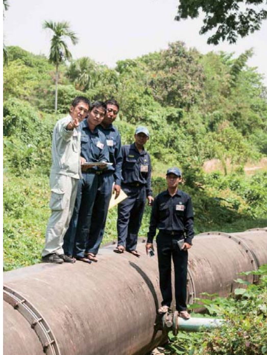
送水管の状況を確認。70年以上経過しているもの、今も現役で活躍中
