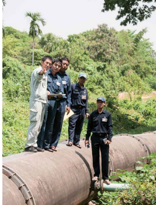
送水管の状況を確認。70年以上経過しているもの、今も現役で活躍中
