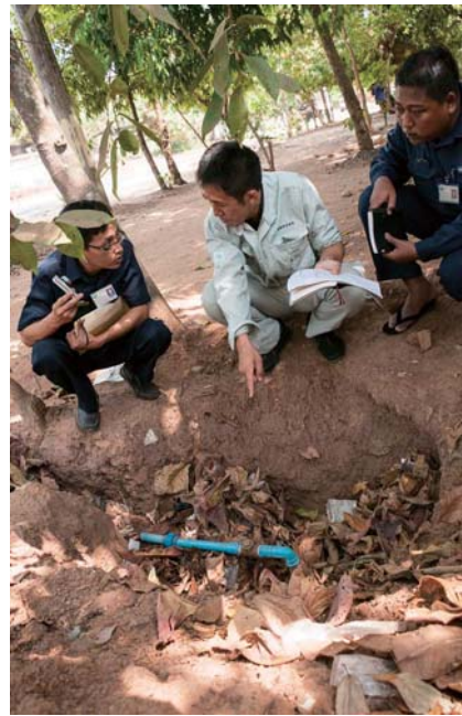
配水管から分岐した給水管の状況を確認する
