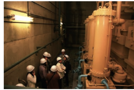
天山発電所の地下に設置された発電機は、佐賀市内から遠隔操作している
