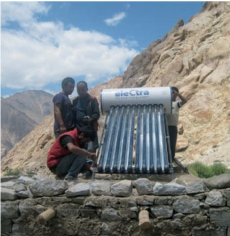
JICA基金で設置されたソーラーウォーターヒーター。太陽光で温められたガラスの管に水を流して温水にする
