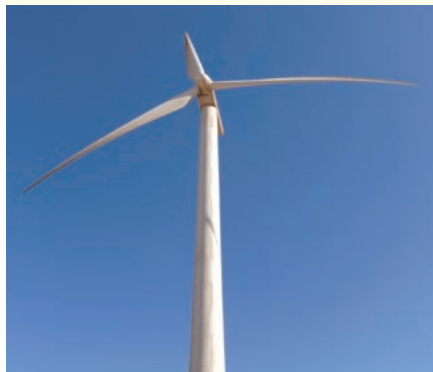
エジプトの砂漠に吹く風を利用した風力発電
