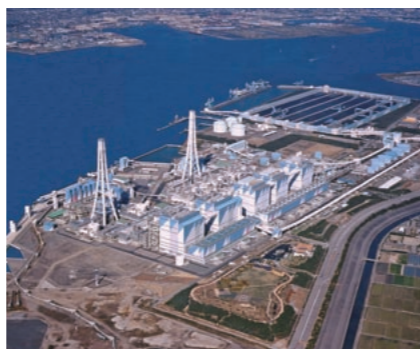
名古屋市の南、約40キロに位置する碧南火力発電所。1号機の運転開始から22年、故障も少なく発電効率を維持している。視察に訪れたインドネシアの関係者らは日本の技術力とCCTの効果を実感したようだ
