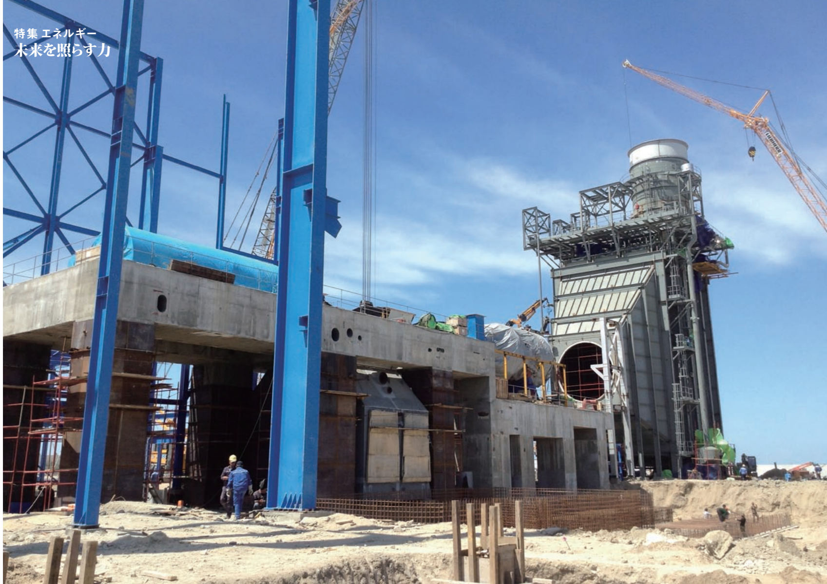
建設中の2号機。ビニールシートに覆われた三菱重工業製のガスタービンと三菱電機製の発電機が据え付けられた
