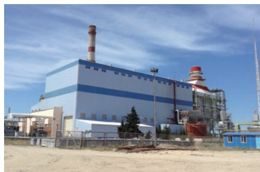
すでに稼働しているシマル・ガス火力複合発電所1号機。首都圏への電力の安定供給に多大な貢献を果たしている
