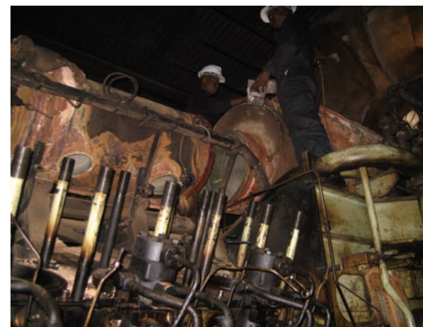
維持管理が行われず動かなくなった発電機のエンジン
