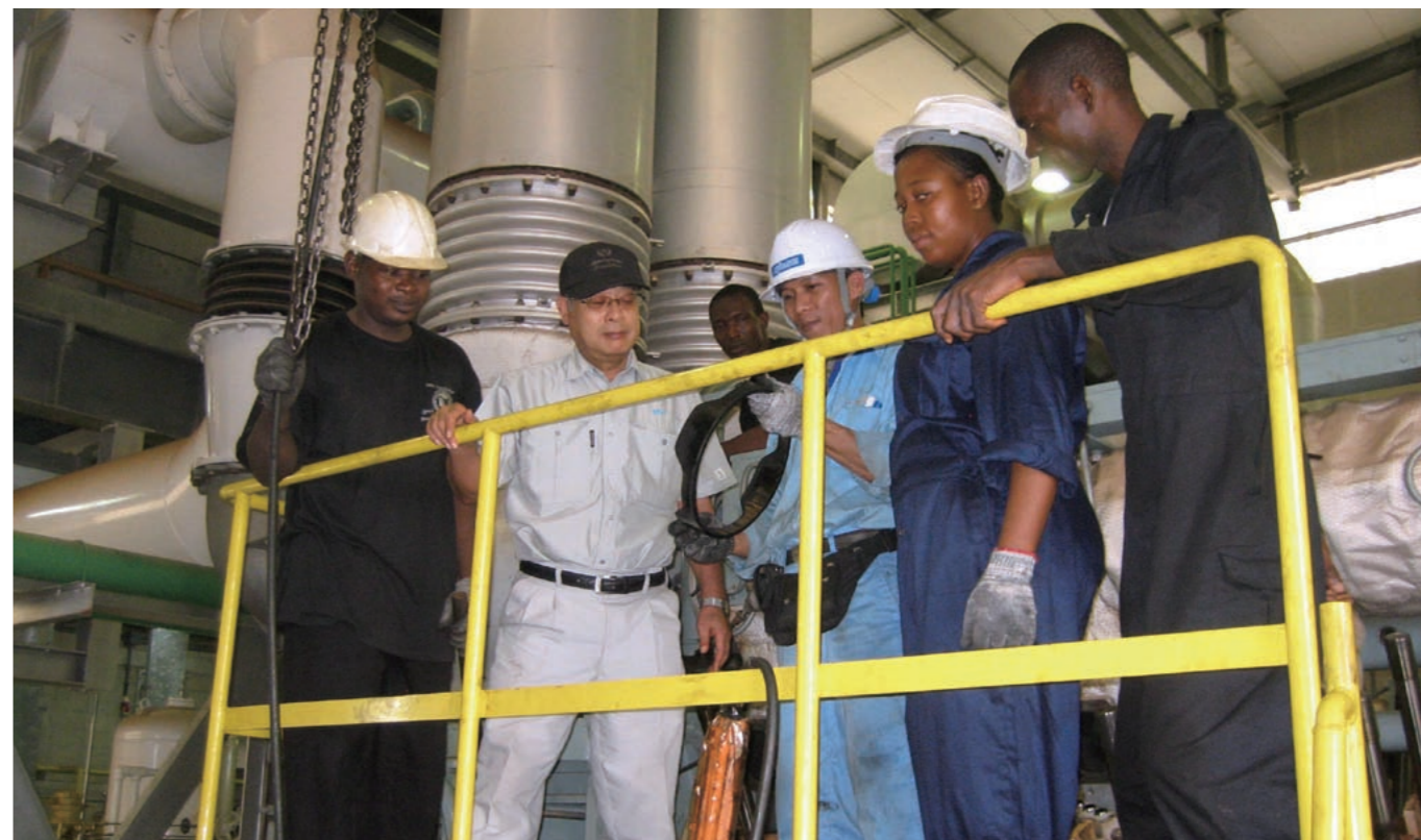
発電機のエンジンに故障がないか調べる方法を伝える松村さん(左から2人目)
