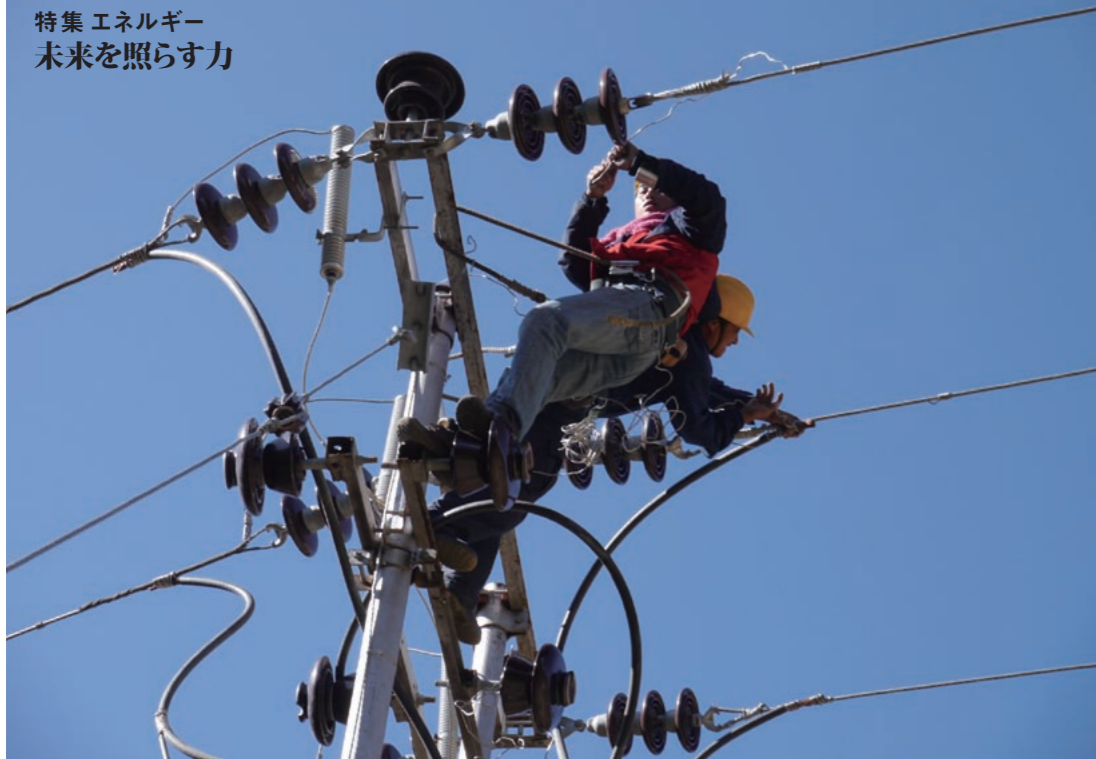
配電設備のメンテナンスを行うBPCの職員。日本製の安全帯を着用
