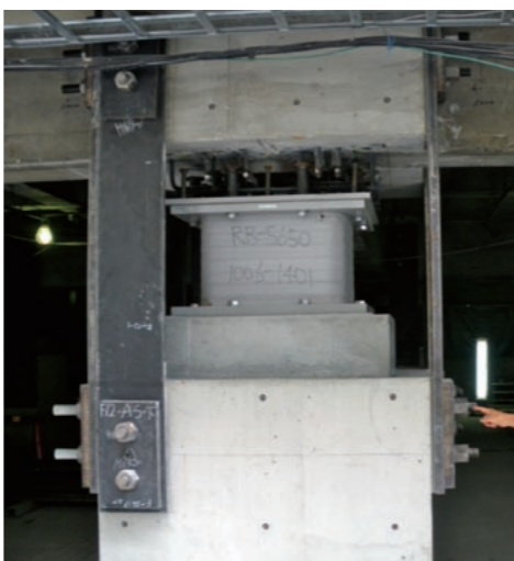
荒川区役所の免震補強の工事の様子。柱の周りを仮設のプレートで支えながら柱を切断し、免震装置を取り付けているところ
