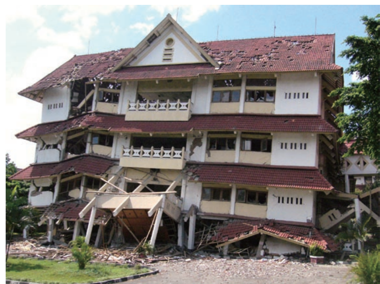
2006年のインドネシアのジャワ島中部地震で被害を受けた建物。多くの途上国では、地震に強い建築方法はまだ普及していない
