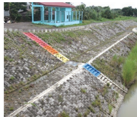
円借款で堤防や放水路が整備されてから、大きな洪水被害は起こっていない
