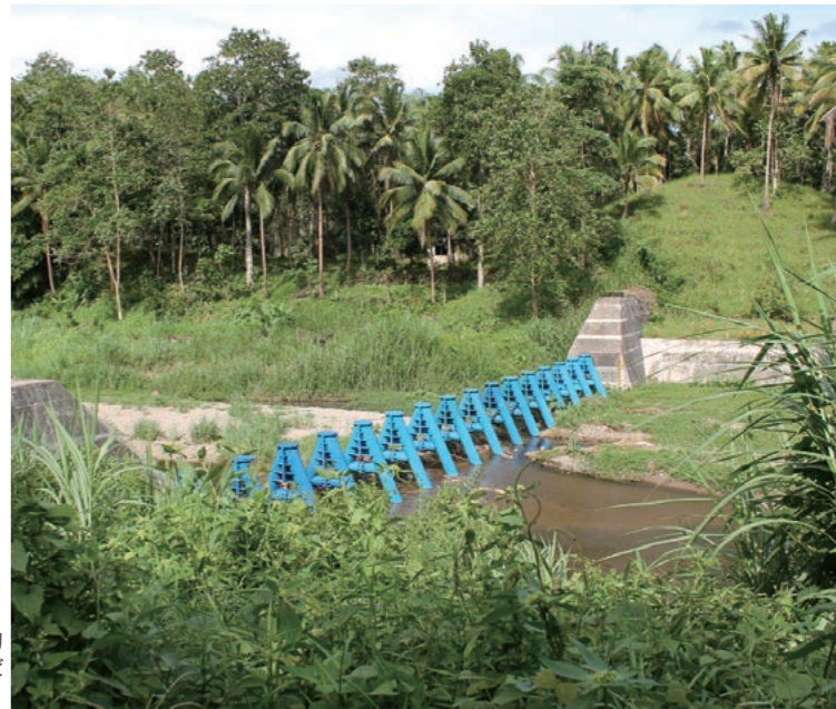
アニラオ川の上流に建設されたフィリピン初のスリットダム。毎月、せき止められた流木などを取り除くなどの維持管理が続けられている
