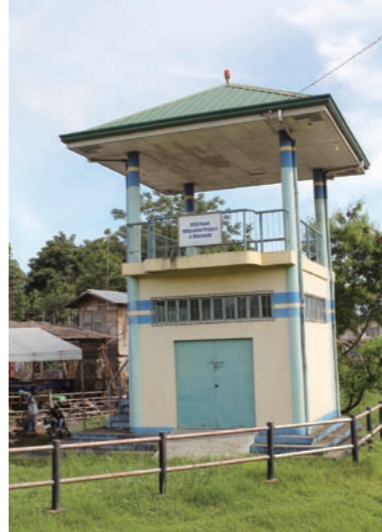
アニラオ川沿いに設置されたフィリピン初の倉庫兼展望台。河川の維持管理に使う機材を保管している
