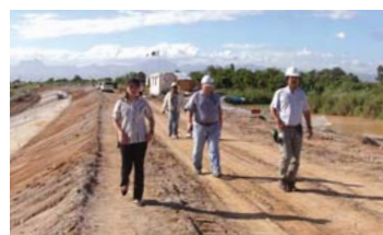
ピナツポ火山周辺の川での護岸工事を視察
