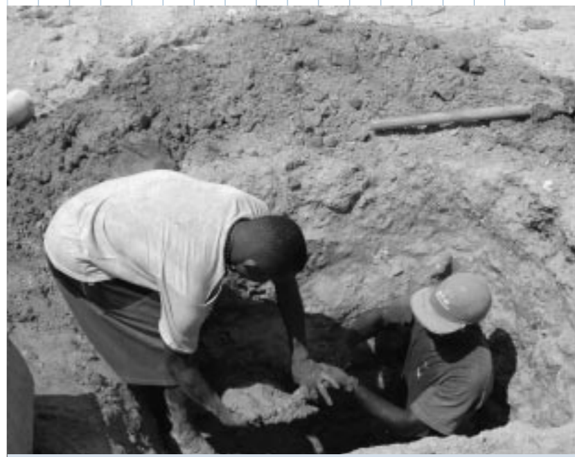
サンタ・アナ村では水道工事が進みつつある
