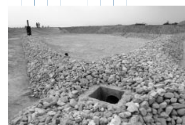
JICAの支援で新しく作られた廃棄物埋め立て場。福岡方式と呼ばれる廃棄物の埋め立て技術が取り入れられている
