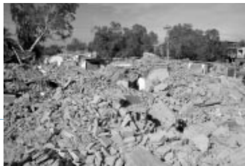
2003年12月26日に発生したバム地震の被災状況。この地域は焼きれんが(アドベ)建築が多く、ほぼ全壊状態だった。テヘランで開発調査を行っていた調査団員が、被害状況調査団として04年1月10日に被災地に入り、永石さんから日本からの団員は13日に合流した
