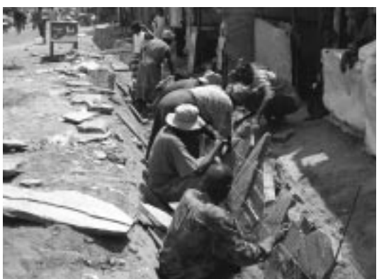
環境衛生活動で、住居脇に排水溝を整備する住民たち
