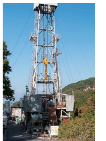
鉄塔につり下げられた掘削機で蒸気を取り出すための井戸を掘る
