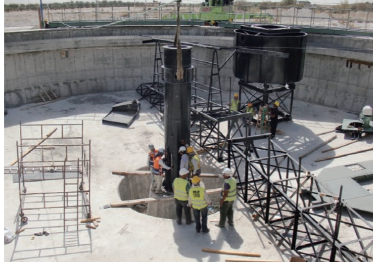
下水処理場の工事を行うパレスチナと日本の技術者たち
