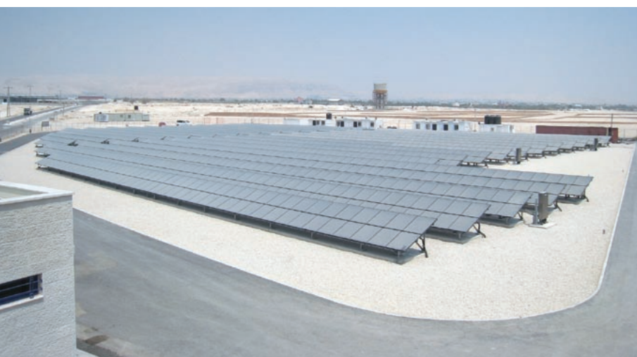
JAIPへ電力を供給するため、日本の協力により整備された太陽光パネル
