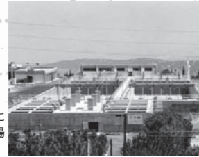
慢性的な水不足に対し、日本は浄水場の建設などを支援
