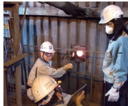
インドの火力発電所で、耐熱カメラの導入に向け現場検証を行った
