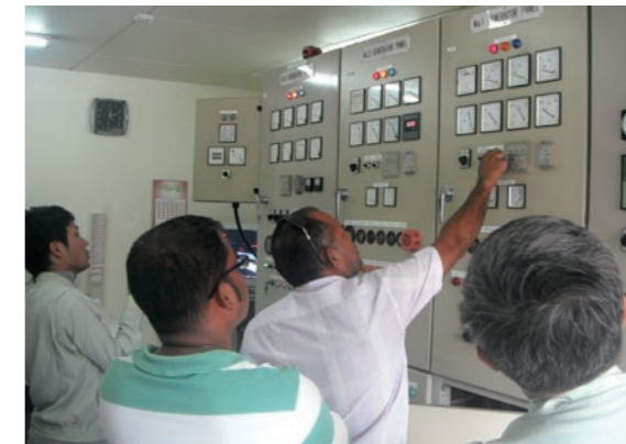
電力事情を調べるため、現地のディーゼル発電所を視察
