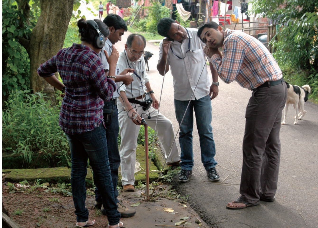
地中の配水管に音聴棒を当て、漏水がないか調べるPWDの職員と日本人専門家
