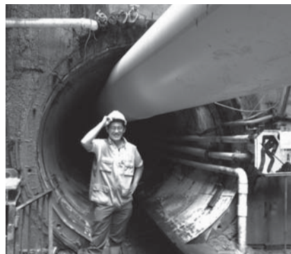
パナマ市東部の下水管の建設現場。事業が予定通り進んでいるか、視察する井上さん
