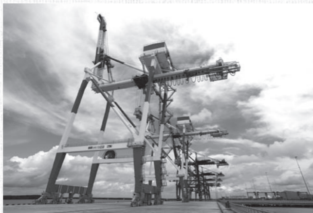
日本企業の進出が増えているベトナムでは、日本の支援により物流の効率化のための港湾整備が行われている(撮影:高橋智史)
