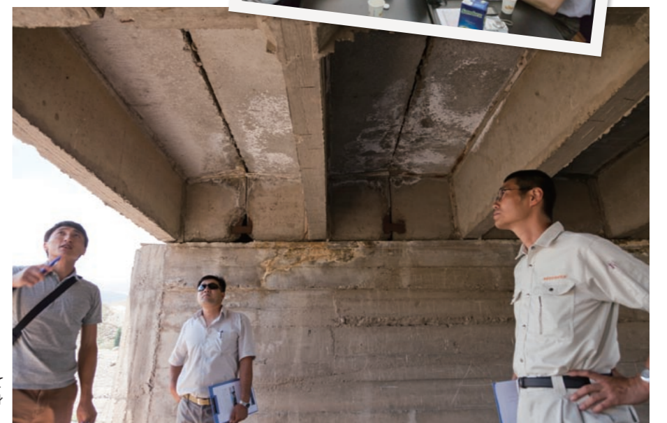
橋桁の下に入り、破損状況について確認する北村専門家(右)。「彼ら自身の維持管理方法を見つけてほしい」
