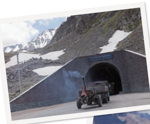
標高3,000メートル地点にあるトンネル。物資を運ぶ大型トラックの通行が多かった
