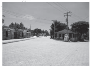
日本の支援によって整備されたレオガン市内の道路
