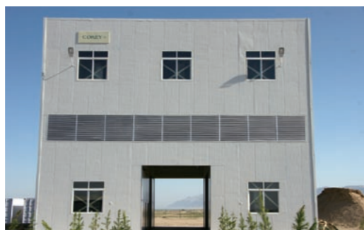
現地に建設した宏輝の工場。甘草の根からグリチルリチン酸を抽出し、加工品を日本へ出荷する
