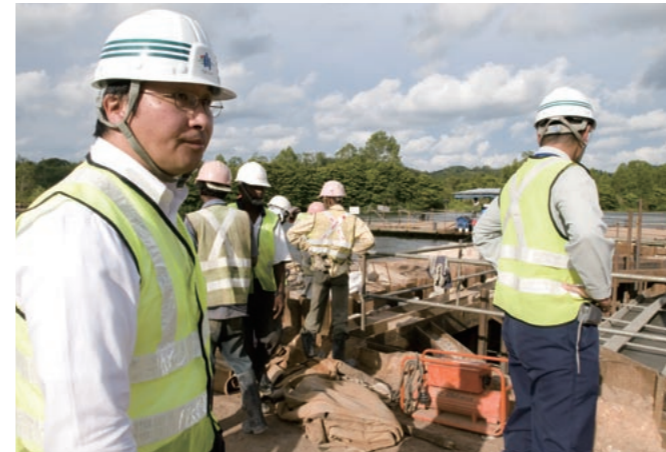
南部高速道路の建設を率いる堀川さん。現場は地盤がゆるく、技術的に苦労も多かった（撮影：谷本美加）
