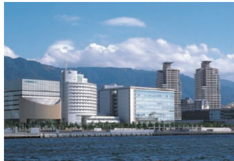
JICA関西が立地する神戸東部新都心(HAT神戸)には、人と防災未来センターや国連国際防災戦略事務局(UNISDR)駐日事務所などの防災関連機関が集積
