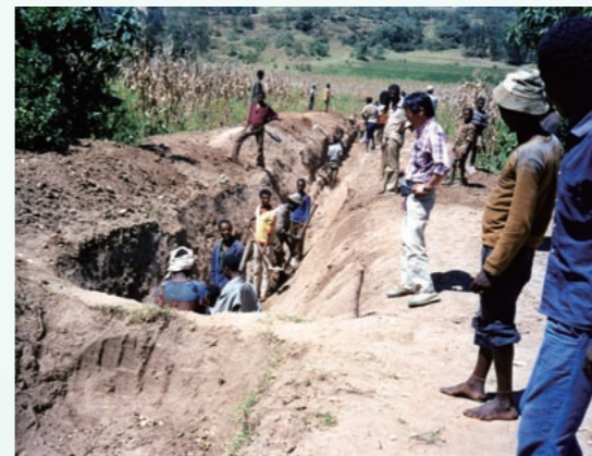
エチオピアの隊員時代。測量や機材の使い方など、試行錯誤しながら現地の人と一緒に土木工事に携わった
