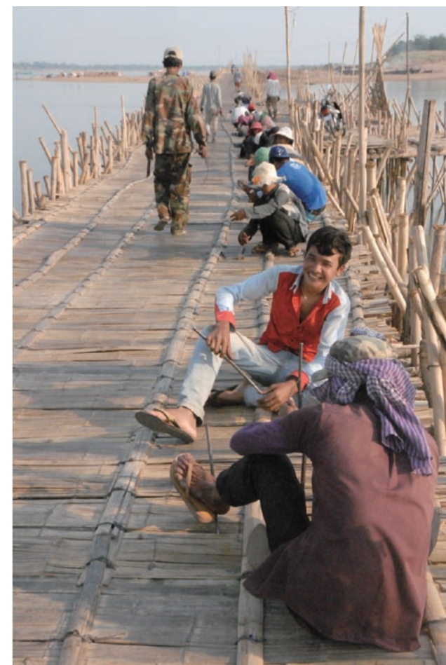
車なども渡るので傷みが激しく、炎天下のもと毎日橋の修復は行われていた
