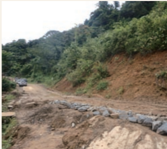
土砂災害後に仮復旧された道路。道幅は非常に狭く、すぐに寸断されてしまう
