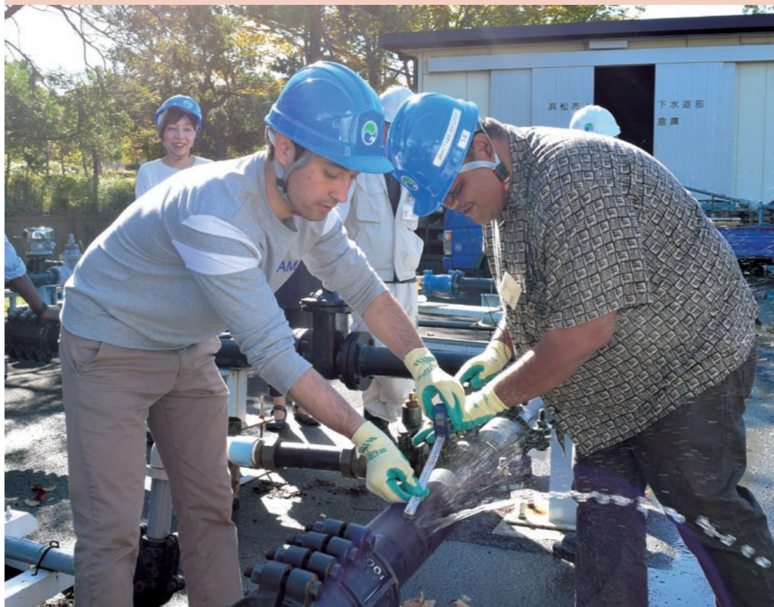
漏水の修繕に挑戦するルスタムさん(左)とクレオファスさん(右)。研修には多くの実習が取り入れられている
