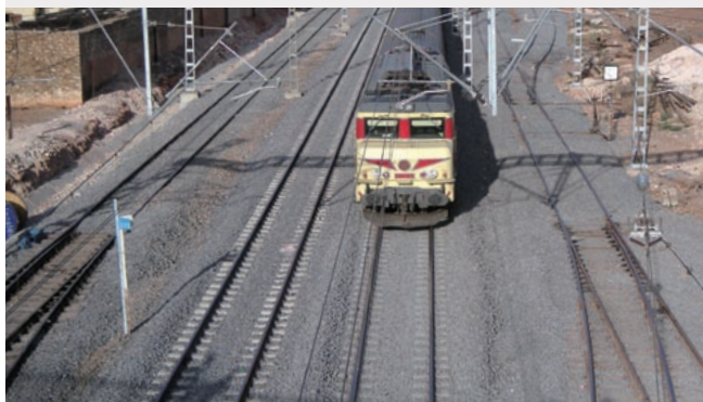
複線化された線路
