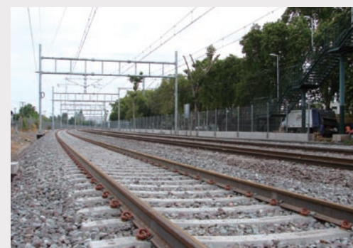
修復された軌道や架線
