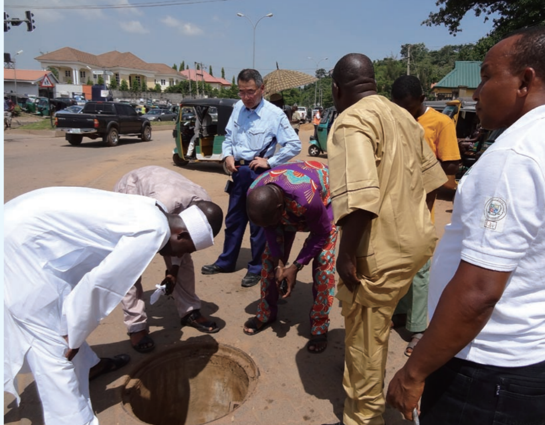
流量計の設置場所・方法をナイジェリアのスタッフと確認。市内に流入する配水量を把握し、アブジャ全体の無取水の状況を把握する
