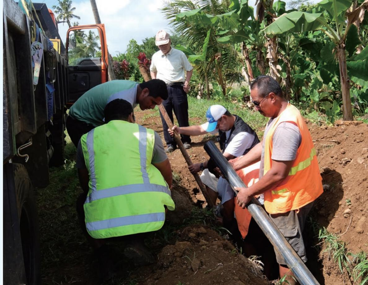
配管接合技術の指導の様子。配管技術の普及と定着は、漏水を防ぐとともに、適切な水圧での給水を可能にする。利用者も快適に水道水を使えるようになる
