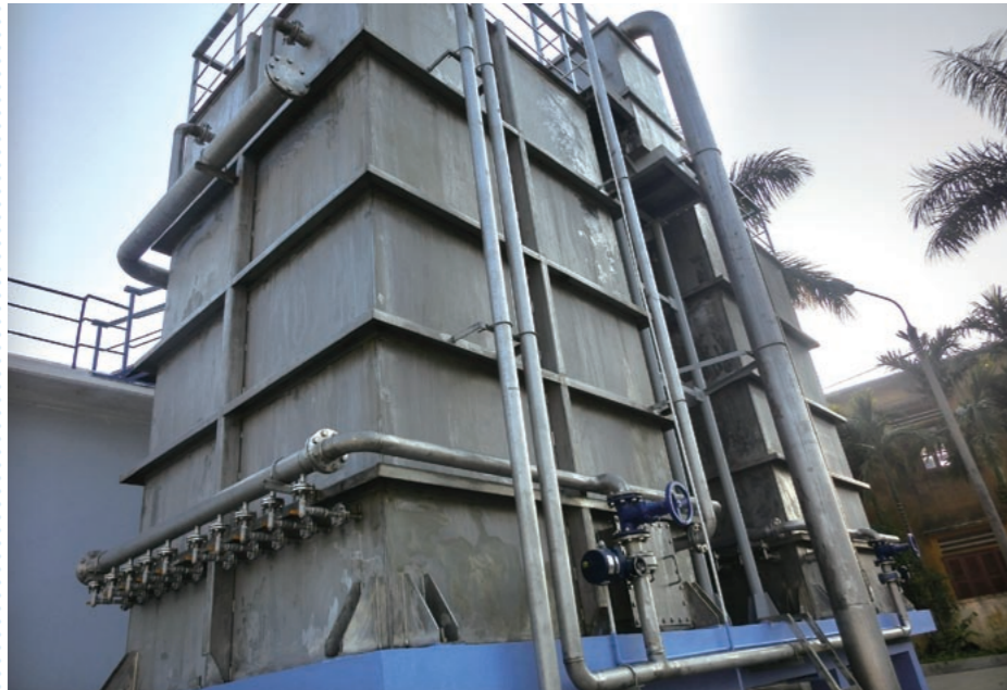
[左]2013年にハイフォン市のビンバオ浄水場に設置されたU-BCFの設備 [下]ハイフォン市の水技術者に対する水質検査の研修(2011年)
