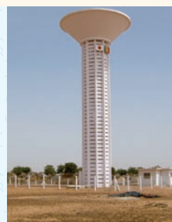
日本の支援で造られた給水塔。地下水をくみ上げて笠の部分に溜めた水は、下へ落ちる圧力で家庭に運ばれる
