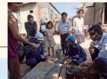
配水管の敷設作業を行うプノンペン水道公社の作業員と地域住民 (提供: 今村健志朗/JICA)
