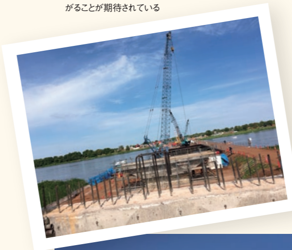
自衛隊と連携してジュバ市内の道路の補修工事を実施。自衛隊が所有する重機を使用した
