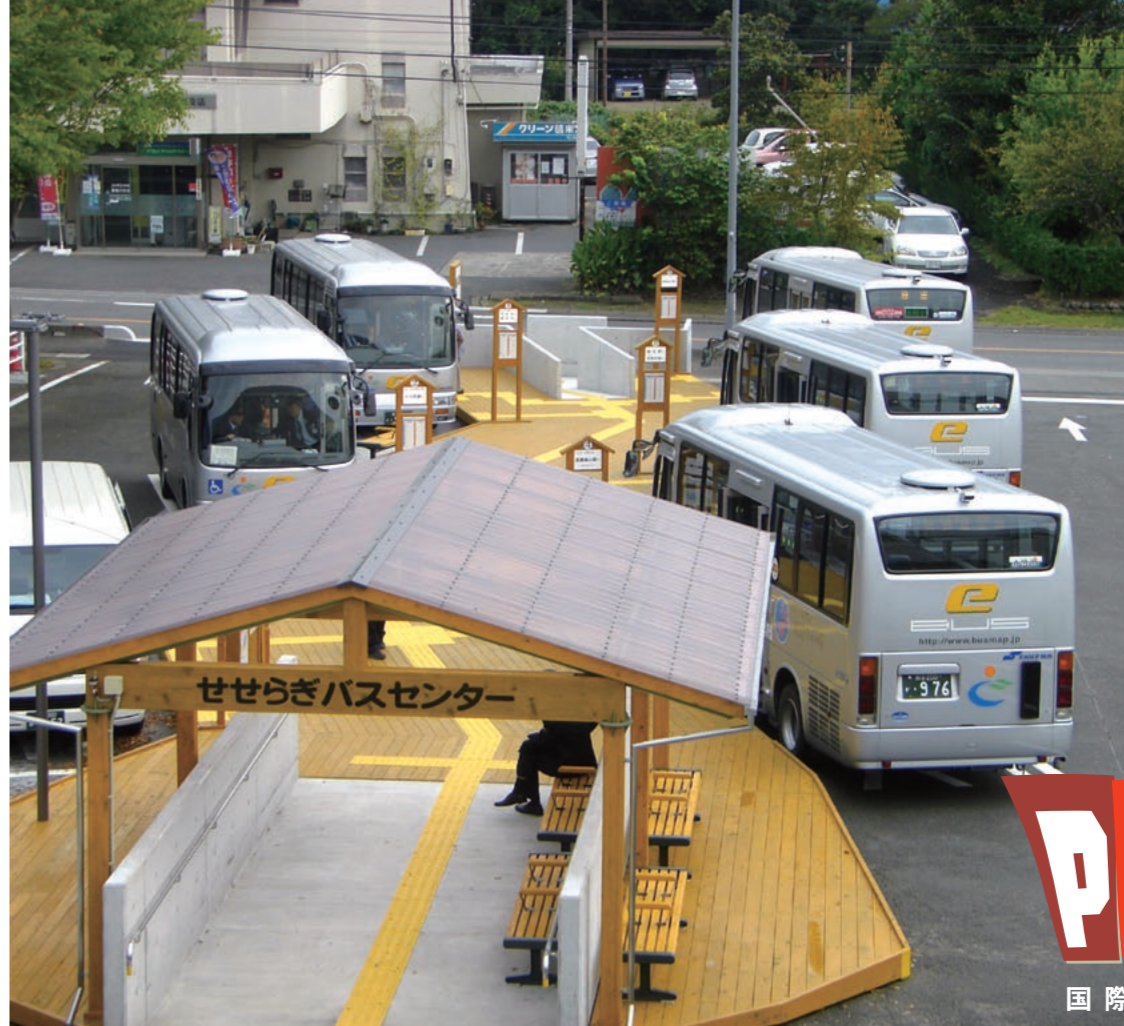
日高市のバス路線のハブとして整備された、ときがわ町のせせらぎバスセンター。市民の足としてだけでなく、観光の拠点としても活用されている
