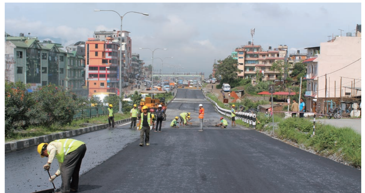
応急復旧工事を実施したKB道路
