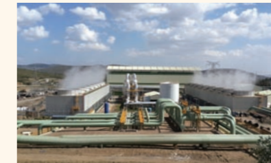
オルカリア地熱地帯の4、5号機地熱発電所(写真提供: JICA)
