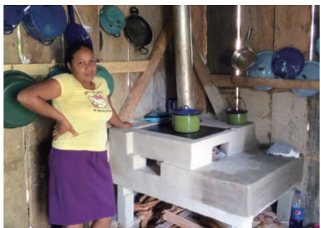
ホンジュラスのマムカ市連合会では、地元の材料を使って改良かまどを製作した。かまど作りをきっかけに台所の整理整頓が習慣になるなど、少しずつ生活全体が改善されていく（写真提供：Mancomunidad MAMUCA）
