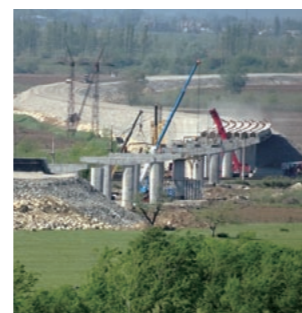
大規模な橋の建設も進められている
