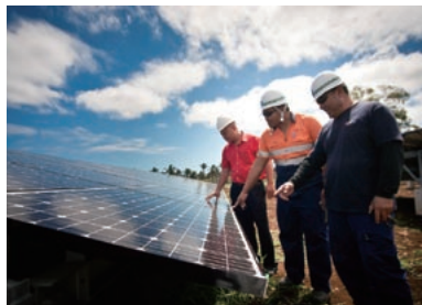
トンガの太陽光発電所で、設備を点検する現地職員たち。赤道に近い大洋州の島々では、太陽光発電の効率は高い
