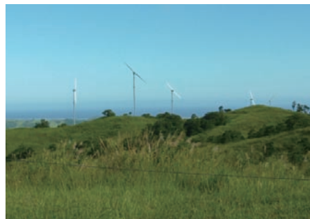
沖縄で使われているのと同じ可倒式の風車は、フィジーにも導入されている
