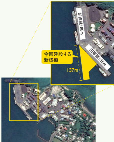
新旧二つの岸壁が「く」の字型になっており、岸壁背後のコンテナヤードの使い勝手を悪くしている。港の中心に当たる新岸壁の背後には危険物を扱う2基の燃料タンクがあり、今後アジア開発銀行の支援で撤去し、跡地をコンテナヤード化する予定だ
