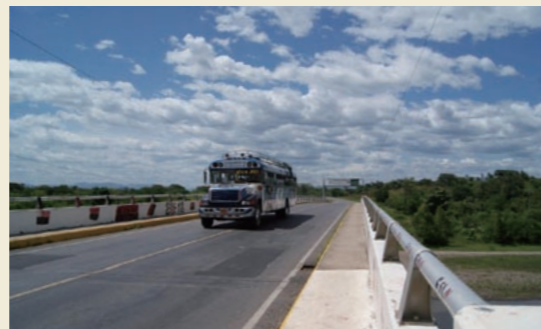
ニカラグア各地に設置された日本の橋が、経済の活性化を支え、人々の夢と希望を運ぶ
