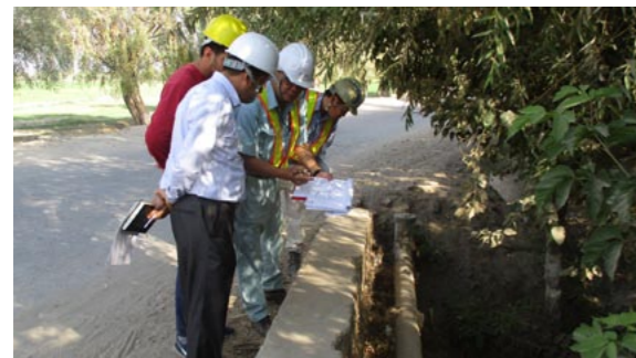
水管橋の施工完了検査を行う、梅原さんの同僚の服部さんと、ピアング上下水道局のスタッフたち
