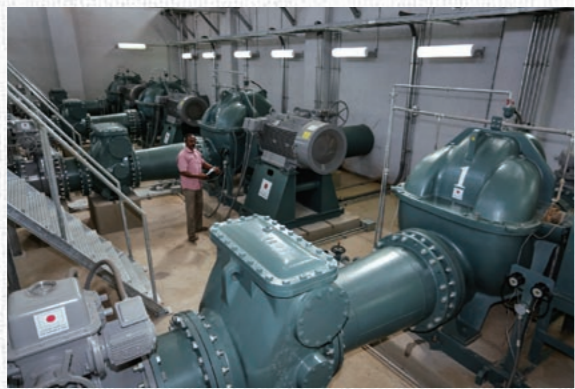
日本の支援により建設された灌漑ポンプ場。ナイル川から水をくみあげている
