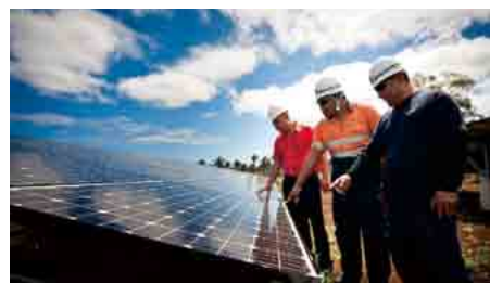
トンガに導入された太陽光発電システム
