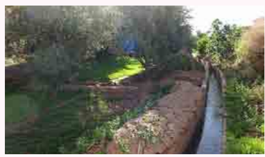
「ティヌリル市イシュマリン集落農業用水路改修計画」で整備した農業用水路。水路脇にはオリーブ、イチジク、ザクロ、牧草が生い茂る(2018年5月撮影)
